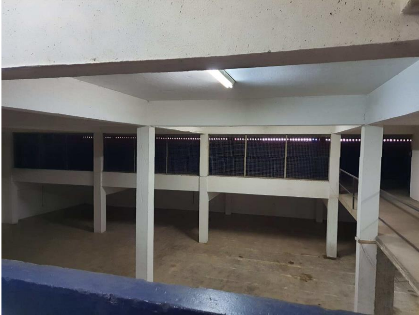
Segundo subsolo, fotos do processo
